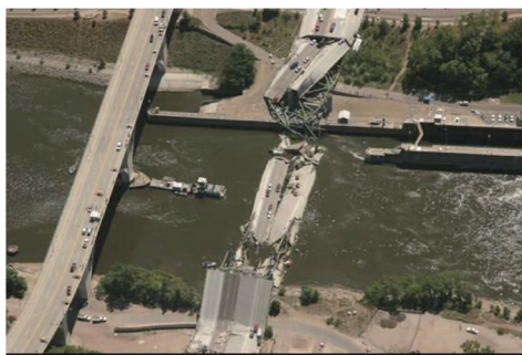
写真1 橋梁崩落事故の状況
