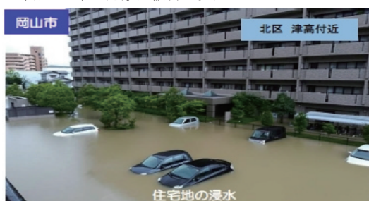
■ 平成30年7月豪雨被害の状況
