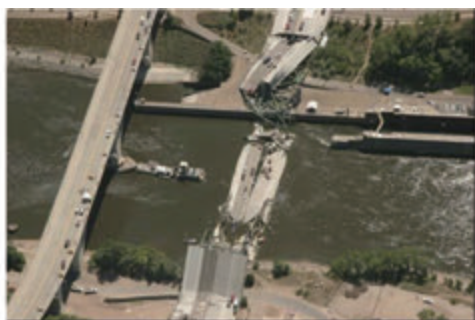
写真1 橋梁崩落事故の状況
