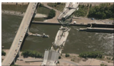
写真1 橋梁崩落事故の状況
