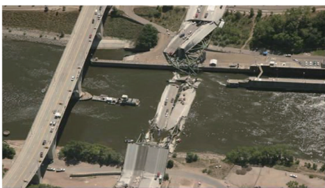
写真1 橋梁崩落事故の状況
