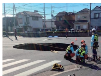
写真：道路陥没の事例
