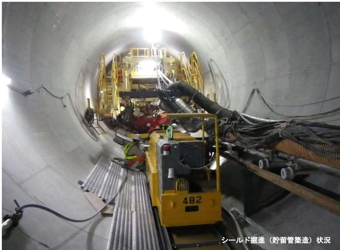
シールド掘進（貯留管築造）状況
