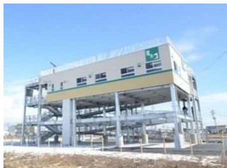
《津波避難タワー（宮城野区中野五丁目）》
