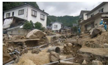
《八木・緑井地区の被災状況》
