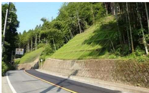
《災害防除工事の施工状況》
